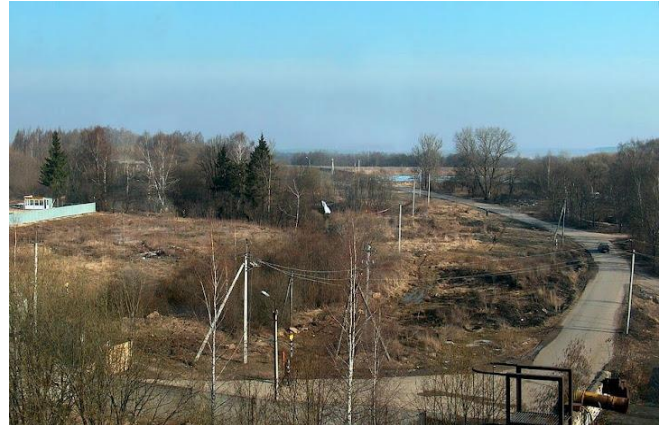
Rys. 3. Wyłączona lub przerwana, przed przylotem samolotu, linia energetyczna, położona w strefie interwencji terrorystycznej [6].
