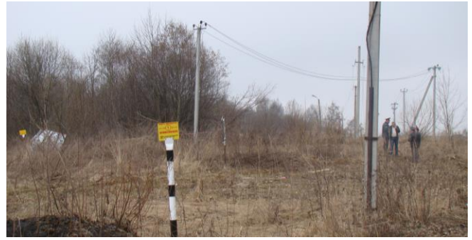
Rys. 14. Linia energetyczna - 777 metrów od progu pasa (zdjęcie z Internetu).
